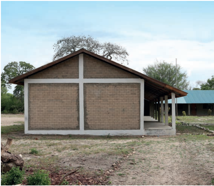
Links: Erstes, mit selbst produzierten Steinen gemauertes Gebäude Rechts: Qualitätsprüfung der Mauersteine aus eigener Herstellung
