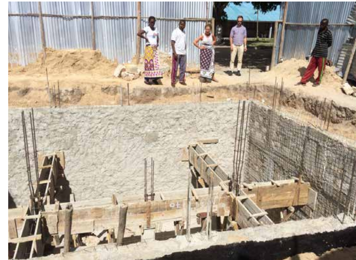
Querträger sorgen für Stabilität
