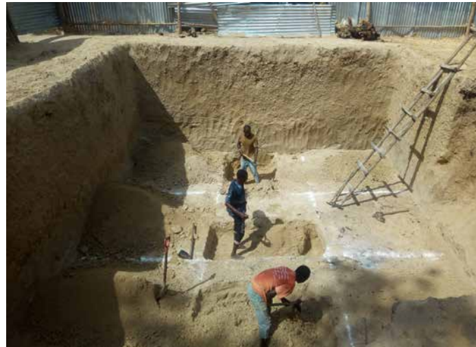
Mit Hacke und Schaufel: Tagelöhner heben die Baugrube aus
