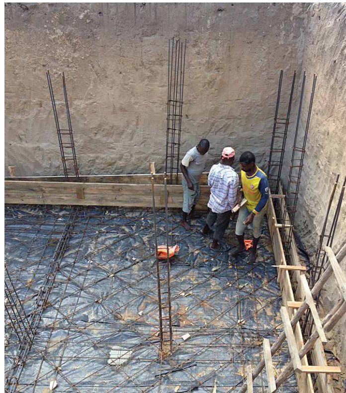
Die große Grube wird zum Tank
