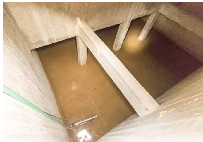
Die Pumpe ist installiert – der Wasserfluss kann beginnen
