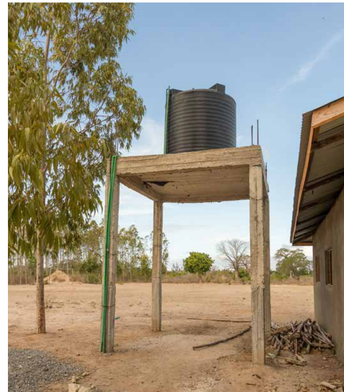
Der Wasserturm sorgt für den benötigten Druck
