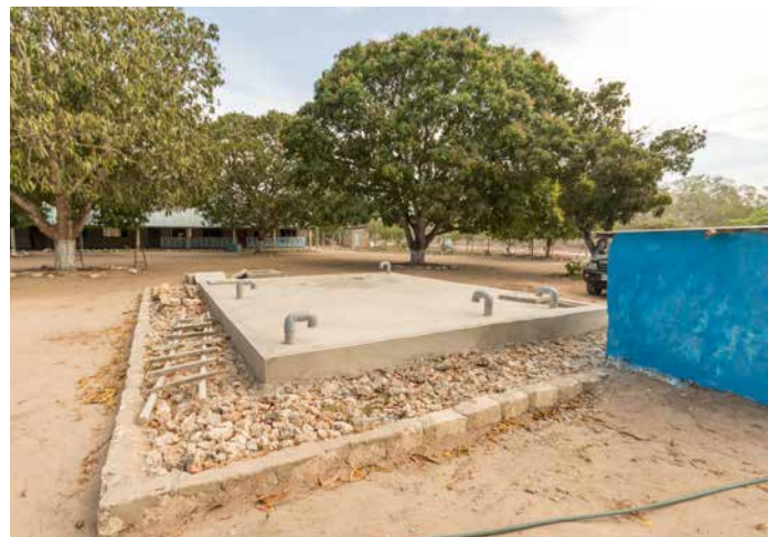
Blick vom Schulhof auf das unterirdische Wasserreservoir
