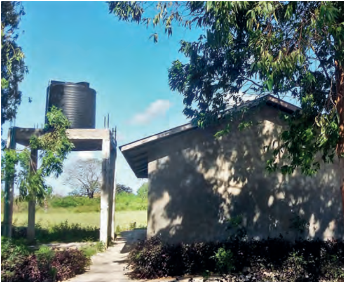
Fließendes Wasser dank Wasserturm
