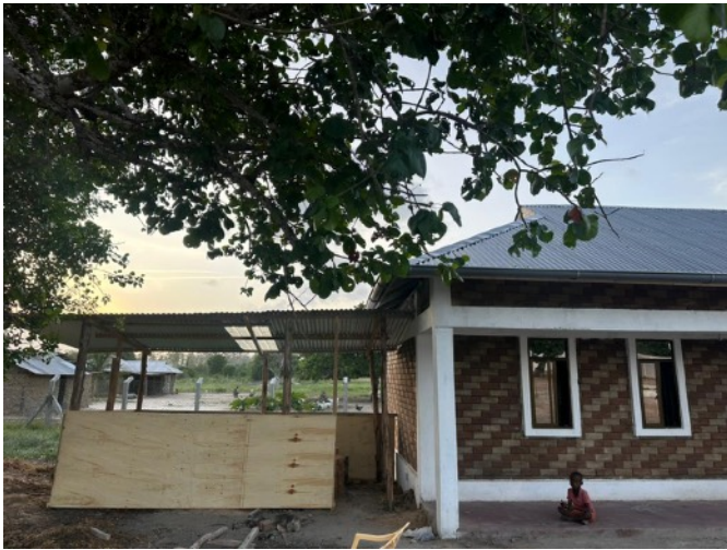
Oben: Aktuelle Behelfsküche neben dem Usalama-House als einfache Holzkonstruktion
