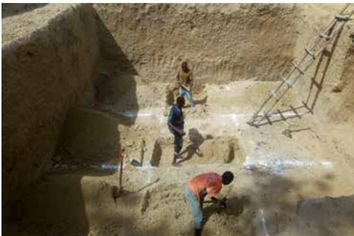
Ganz oben: Neue Schulbänke dank lokaler Spenden Links oben: Sichtbare Renovierungsarbeiten Links Mitte: Vermessung des neuen Schulgebäudes Links unten: Aushub der Baugrube für den 90000 l Regenwassertank
