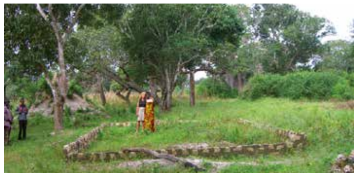
Projektbeginn im Jahr 2008; Bau des 1. Gebäudes
