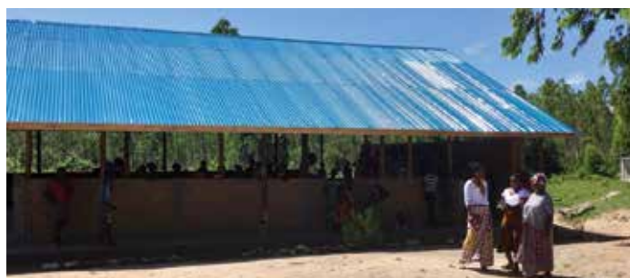
Die fertiggestellte Mensa komplettiert das Schulgelände
