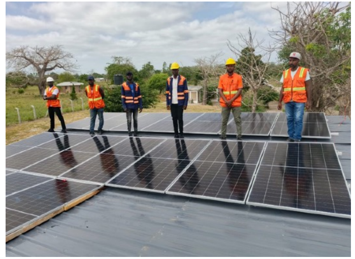
Oben: Einweihung der Solaranlage auf dem Dach der Secondary School durch lokale Experten
